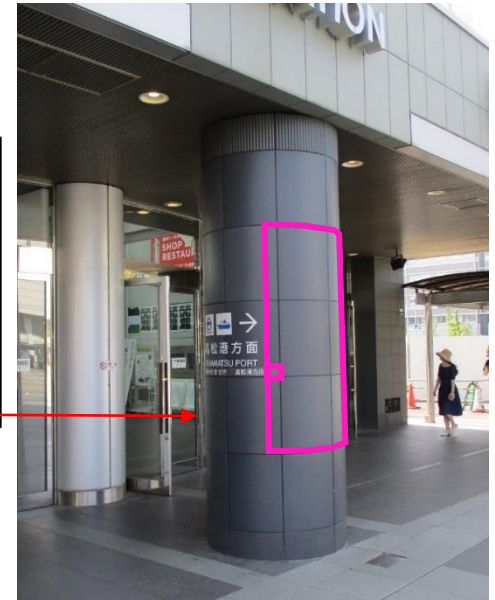
ピクトサインに一部重ねてシート貼りします。シート幅が1.14mより大きい場合はセンター位置がずれます。
